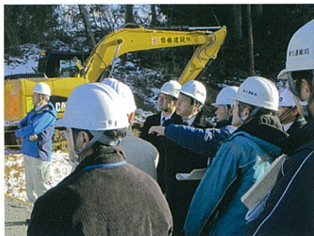
宮城県東松島市の JR仙石線の新野蒜駅工事現場（2月8日）
