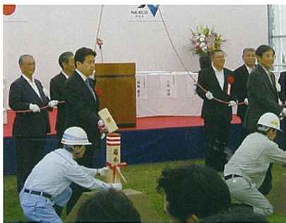
早期完成めざし杭打ち（御坊市日高川ふれあい水辺公園、隣は仁坂知事）
